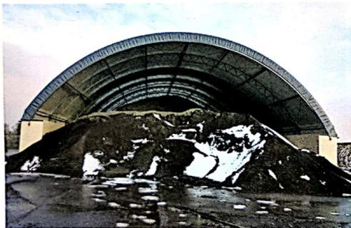
LURA propose des cloisons hyper résistantes. Sur celles-ci, il est possible d'installer des toitures fixes de 12 à près de 45 mètres de portée. Les caractéristiques statiques sont exceptionnelles. Ici, un bâtiment de 20 mètres dans lequel des fraisés de densité 1,8 sont stockés, presque sans faitage.
